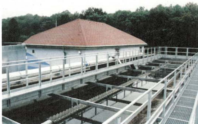
Abb. 9: Kläranlage Jaroměř mit einer Kapazität von 35 000 EGW. Inbetriebnahme: Juli 1995
