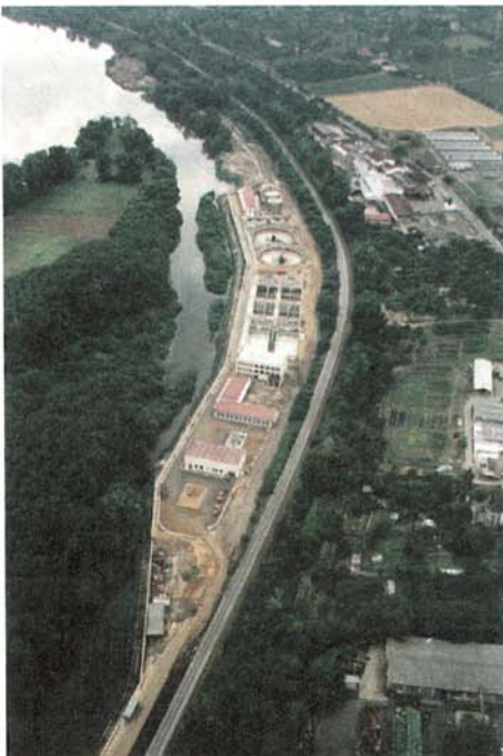
Abb. 3: Kläranlage Litoměřice mit einer Kapazität von 111 000 EGW. Inbetrieb- nahme: Oktober 1994
