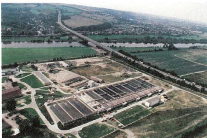
Abb. 7: Kläranlage Dresden-Kaditz mit einer Kapazität von 700 000 EGW. Inbetriebnahme: Juli 1993
