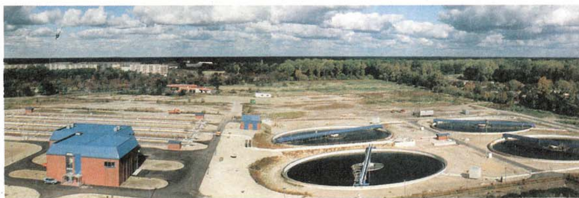
Abb. 8: Kläranlage Cottbus mit einer Kapazität von 300 000 EGW. Inbetriebnahme: September 1994
