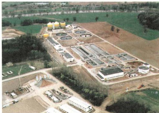
Abb. 4: Kläranlage Hradec Králové mit einer Kapazität von 180 000 EGW. Inbetriebnahme: Dezember 1995
